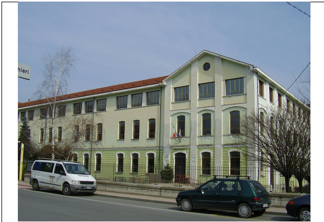
Foto n° 1 – Prospetto principale edificio scolastico
